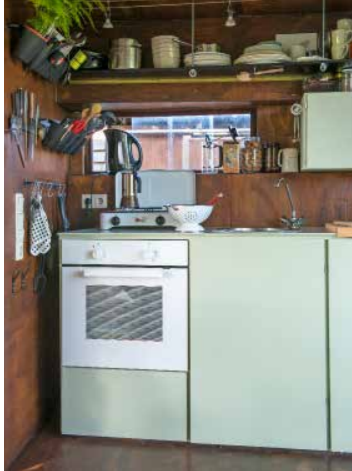
Met draadeinden is de plank aan het plafond geschroefd.
